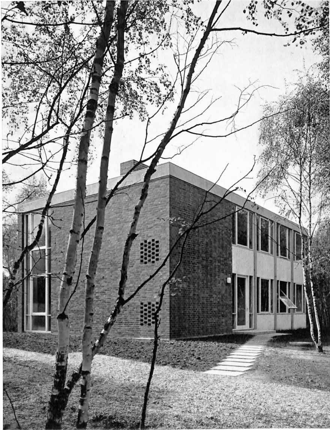
Abb. 3: Werkstattgebäude der NGM auf dem Gelände der Akademie der Bildenden Künste Nürnberg Fig. 3: Workshop of the NGM on the grounds of the Nuremberg Academy of Arts
